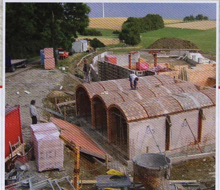
Die Käsereifungskeller werden aus vorgefertigten Teilen zusammengesetzt und können später mit Erde überdeckt werden
