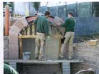
Anlieferung und Einbau des vorgefertigten Ziegelgewölbes.
