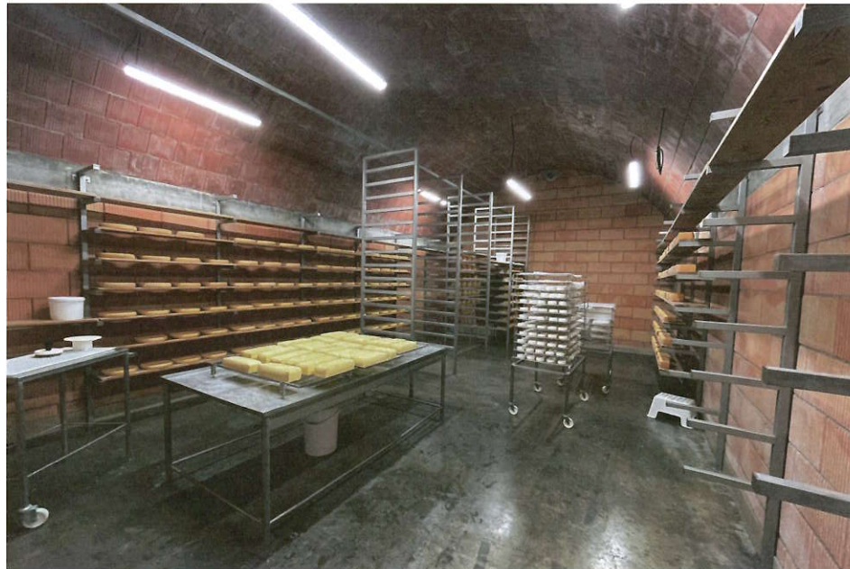
Abbildung 1: Offenporiges Ziegelgewölbe in der Hofkäserei Heggelbach
