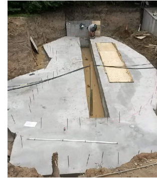
Anspruchsvolle Aufgabe: Die Poolabdeckung für den geschwungenen Schwimmteich wurde auf dem Grund montiert – noch vor dem Bau der Wände des Schwimmteichs.
